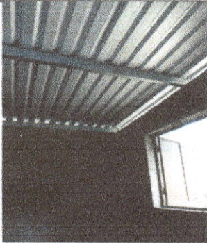
Foto 1: Sustitución de estructura de soporte de madera, por metal
